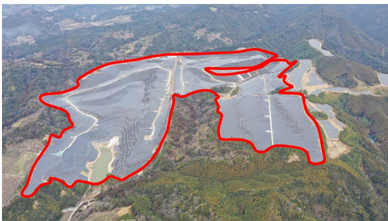
※パシフィコ・エナジー和歌山メガソーラー発電所は赤枠部分。
